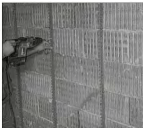
fig. 3.1 Posa dei binari su parete mediante tasselli
